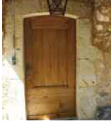
Remplacement porte du presbytère
