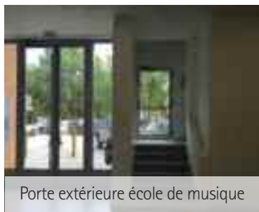
Accès extérieur école de musique
