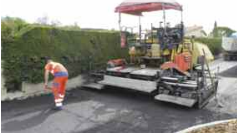
Réfection de la chaussée chemin des Tourres
