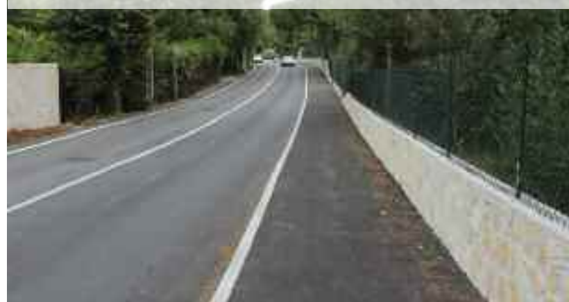
Rte de Valbonne : trottoir et réfection de l'enrobé - 250.000€ (Conseil départemental)
