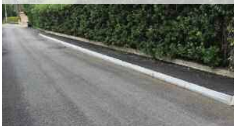
Réalisation de purge de chaussée et réfection de l'enrobé chemin de Vaugailière
