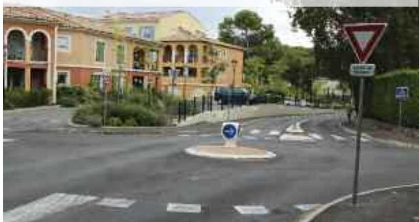
Création d'un rond-point sur la route de Valbonne
