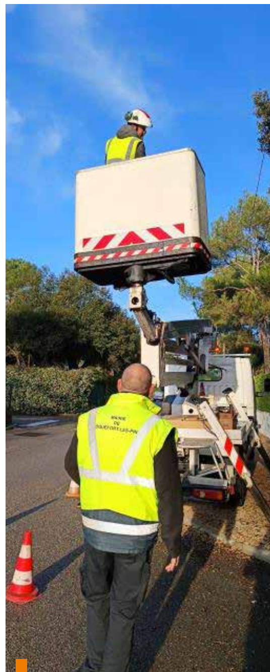
Les équipes municipales à l'œuvre pour l'installation de l'éclairage public.
