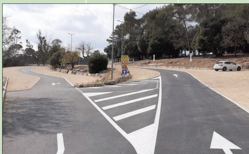
Parc des Sports - Aménagement des parkings Chaussée en enrobé, signalisation au sol, évacuation des de eaux pluviales et aire de covoiturage sécurisée Coût : 138.000 €
