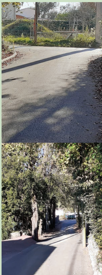
Chemin du Gagäi Reprise de chaussée et création de bordures Coût : 58.600 €
