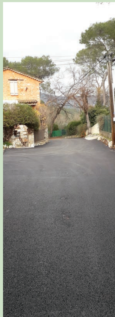
Chemin des Tourres Reprise de chaussée en enrobé Coût : 20.810 €
