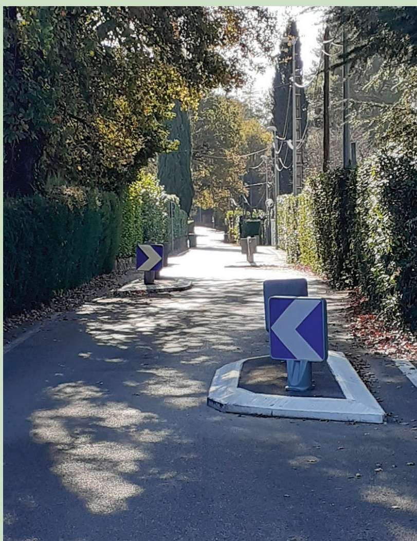
Chemin de Peire Luche Reprise de chaussée, création de chicanes de ralentissement Coût : 102.450 €
