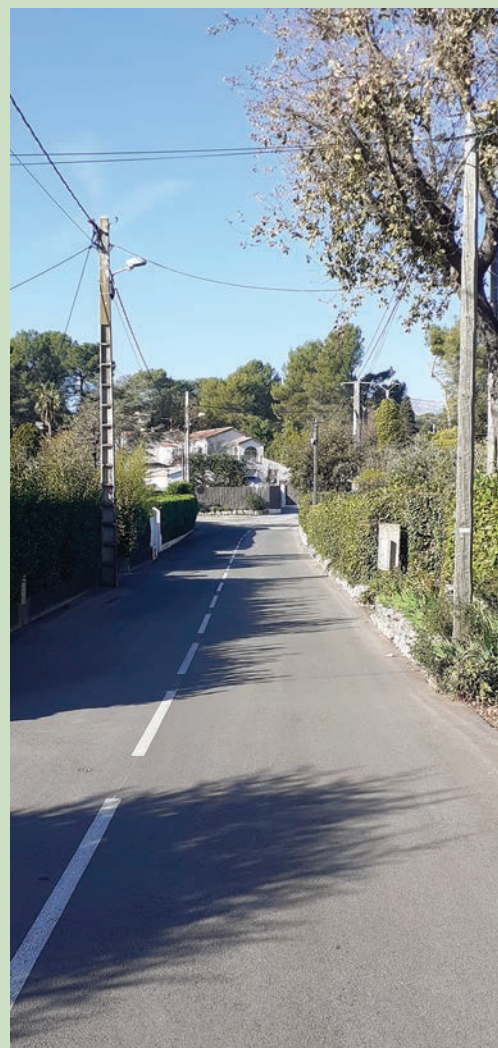
Chemin des Pignatons Reprise de chaussée en enrobé Coût : 62.930 €
