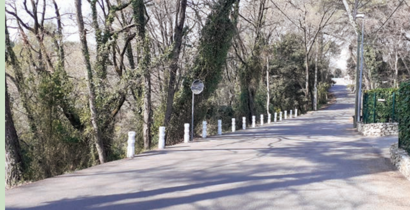
Chemin du Camouyer Reprise totale de l'enrobé et sécurisation de la circulation Coût : 68.850 €
