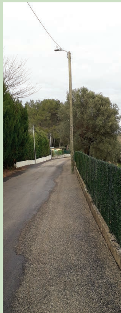
Chemin de la Gorgue Création d'un trottoir et travaux d'accotements Coût : 25.700 €
