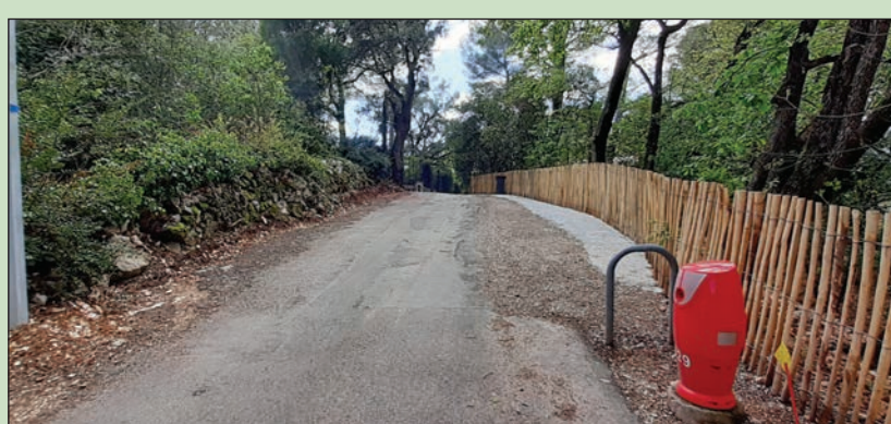
Les Suves Elargissement de chaussée et sécurisation incendie Coût : 12.400 €
