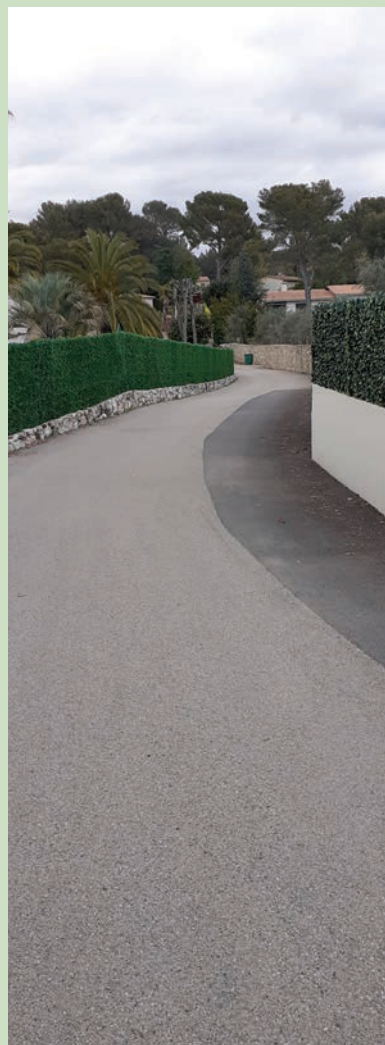
Plateau Fleury Aménagement de chaussée en enrobé Coût : 3.465 €
