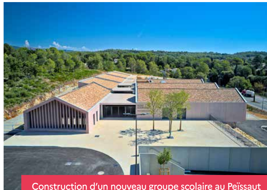
Construction d'un nouveau groupe scolaire au Peïssaut
