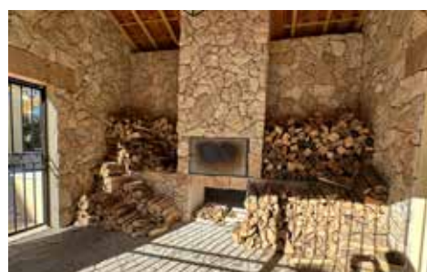
Réalisation d'un four à pain dans le centre village
