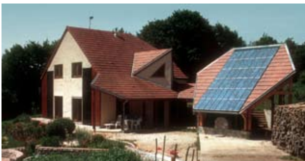
Maison équipée de modules photovoltaïques, dans le Doubs
